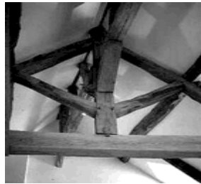
les poutres du grenier
