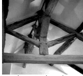
les poutres du grenier
